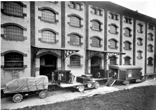
199 Lagerhaus Giesshübel, Zürich, 1932
